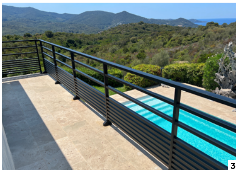
1- BRIEL : Pose sur dalle sur sabot et fixation tableau - Main courante rectangulaire KAY - Gris anthracite 7016. 2- DEK : Pose sur dalle sur sabot - Main courante arrondie SOA - Gris sablé G2900. 3- LOIG : Pose sur dalle sur sabot - Main courante rectangulaire KAY - Noir foncé 9005.
